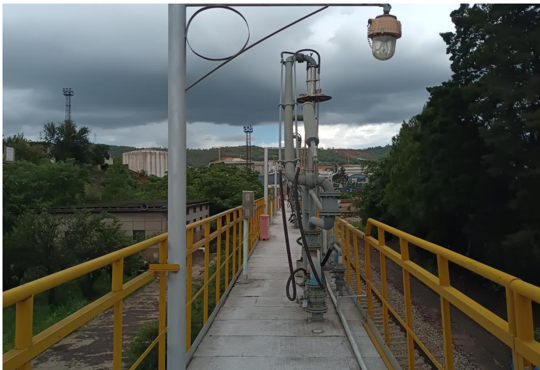
图 2-3 铁路卸油栈桥
